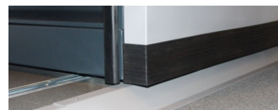
Rodapé de proteção no painel frontal, e frizo de vedação em neoprene entre os módulos
